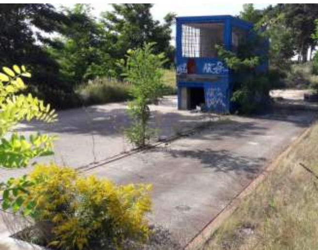
ehemaliger Eingang insolvente Grube West
