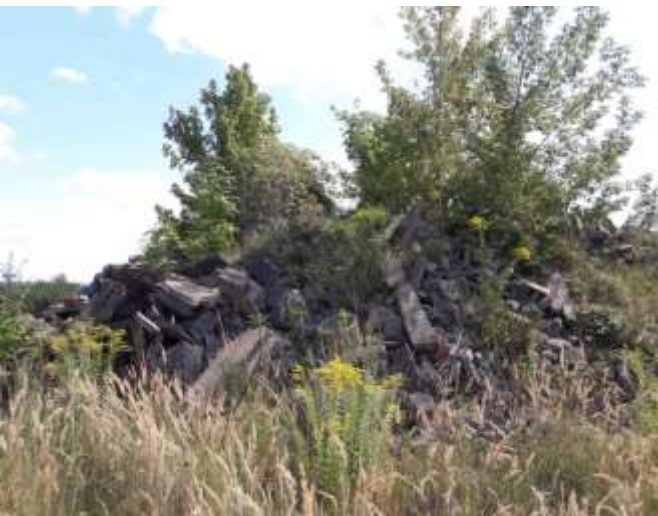
Bauschuttmassen östlich des Vorranggebietes
