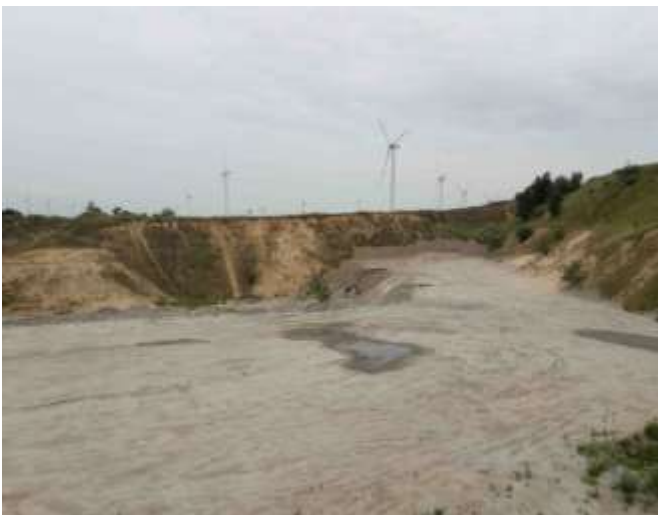
Grubenbereich mit Bauschuttverfüllung
