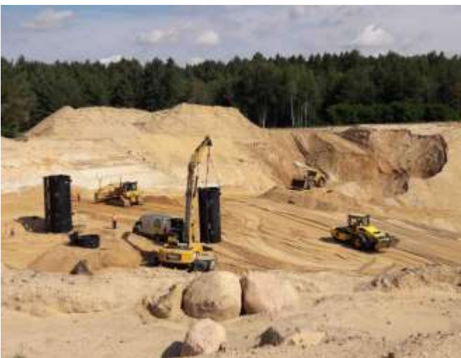
Einbau Deponiesickerwasserüberwachung
