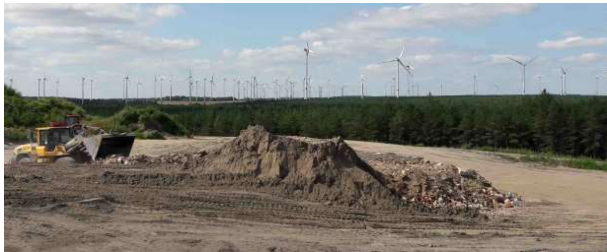
Bauschuttdeponie im Süden der Grube – verfüllt bis in Höhe umliegender Baumwipfel
