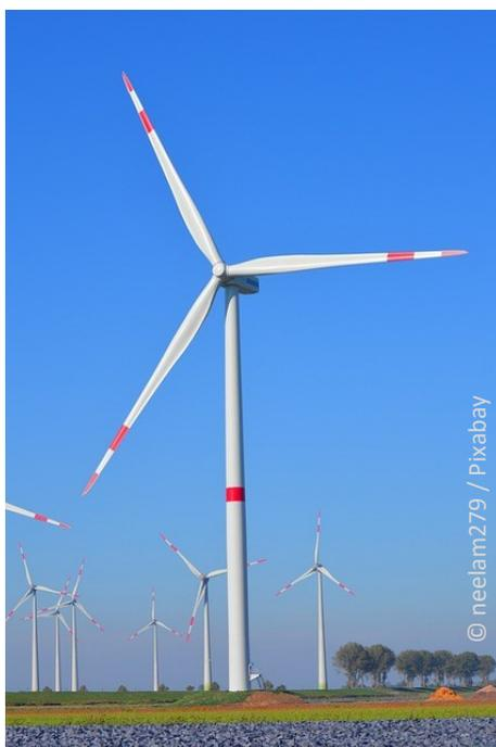
*Beim Repowering bleibt nur jede zweite Windenergieanlage stehen, da die einzelnen neuen Windräder sehr viel leistungsfähiger sind als die alten Windräder. Mit weniger Anlagen wird mehr Strom produziert.*
